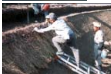
▲ため池の復元 突き固めの体験
